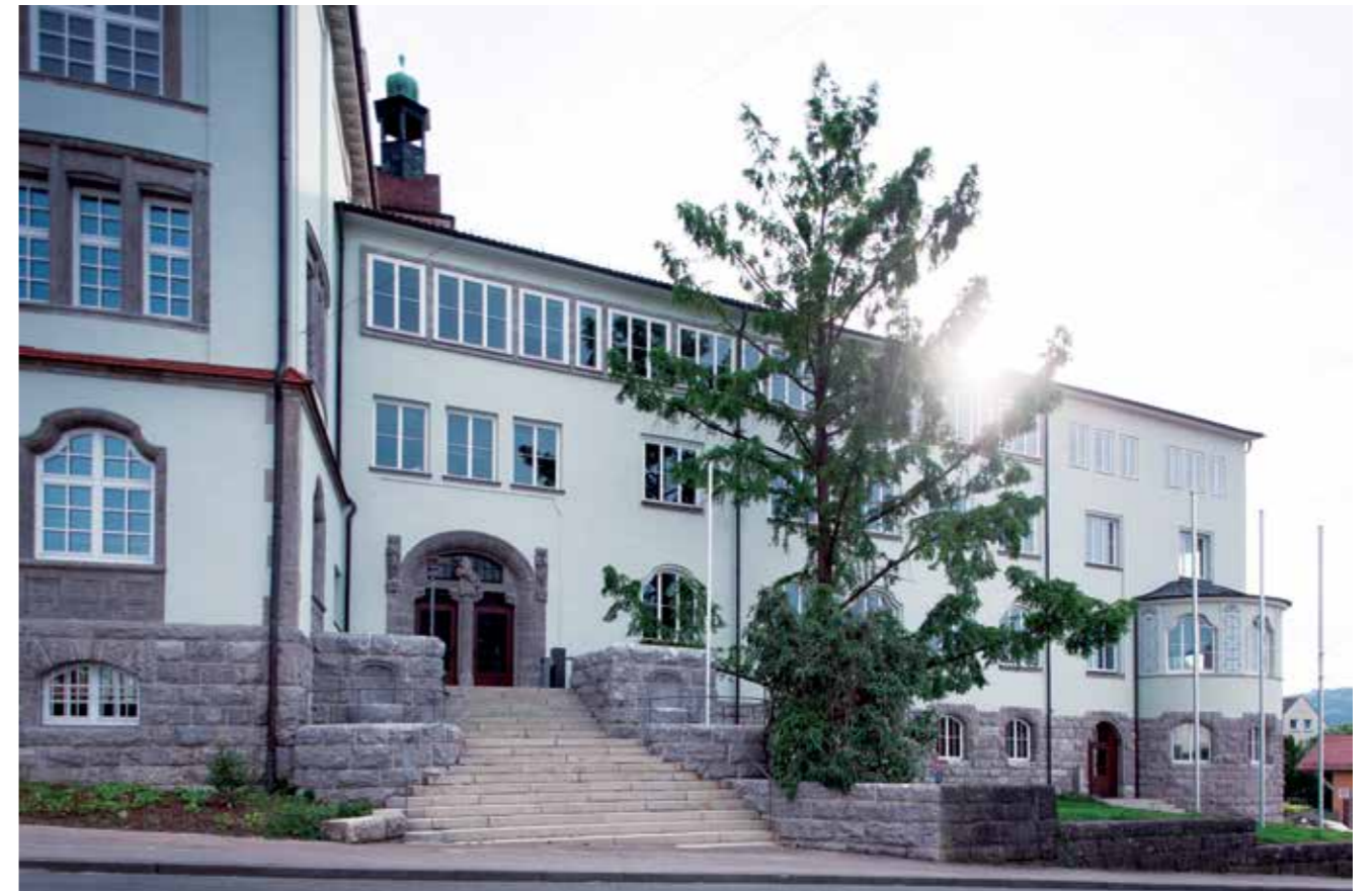
Building Hochschule für Gestaltung Schwäbisch Gmünd | photo: Pascal Dreier
