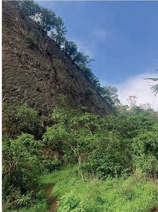
Figura 4. Pared reverberante, en relación a la posición del micrófono se colocó hacia la parte trasera.
